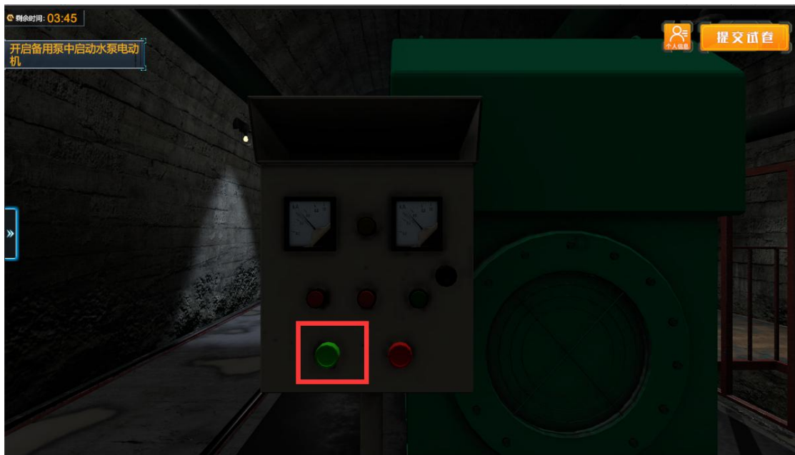
完成开启备用泵中启动水泵电动机
